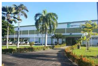
Conclusão da subestação do Campus João Pessoa
