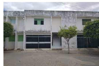
Realização de reforma na sede provisória do Campus Santa Luzia
