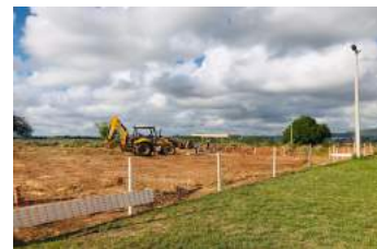
Construção da quadra poliesportiva do Campus Guarabira
