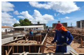
Início da construção da nova sede Administrativa da Reitoria
