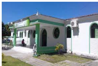
Reforma no Campus Avançado Cabedelo Centro
