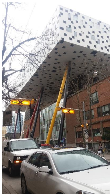
Prédio da OCAD fundindo a arquitetura tradicional vitoriana com a moderna.
