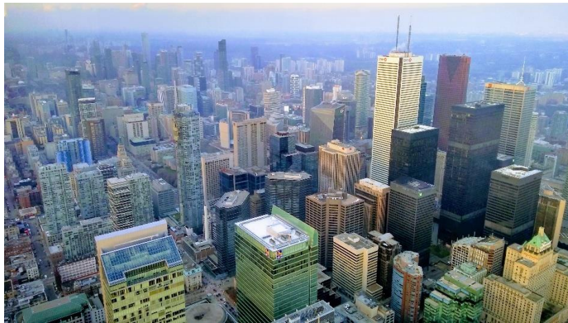
Figura 19. Vista da cidade a partir do topo da torre.
