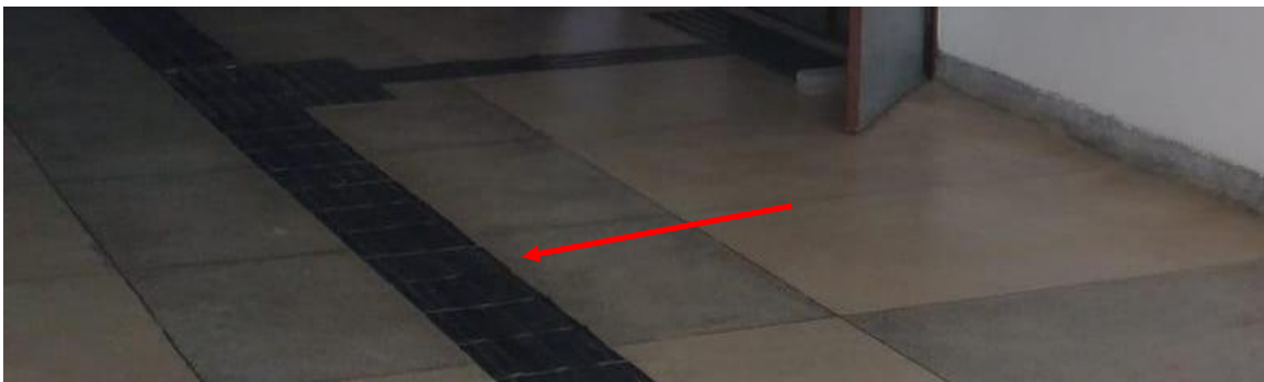
Foto: piso com revestimento emborrachado
