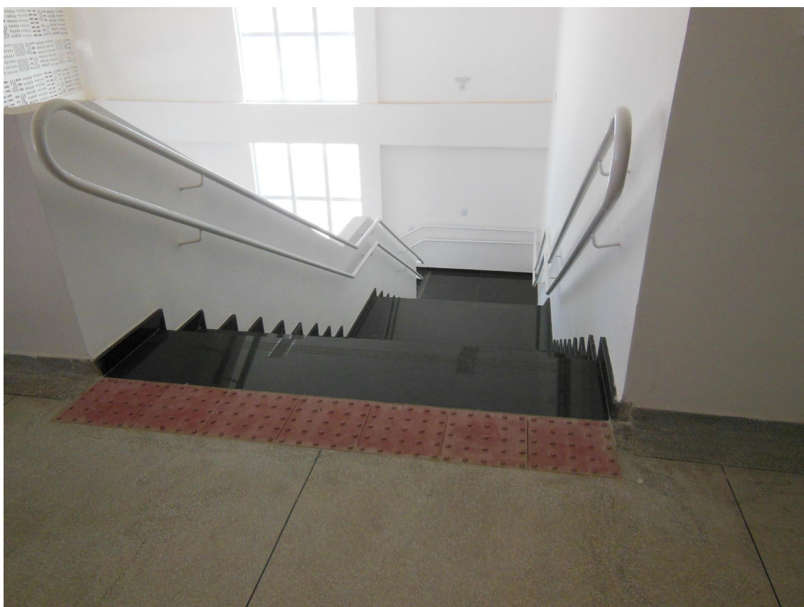
Foto: escada de acesso em granito
