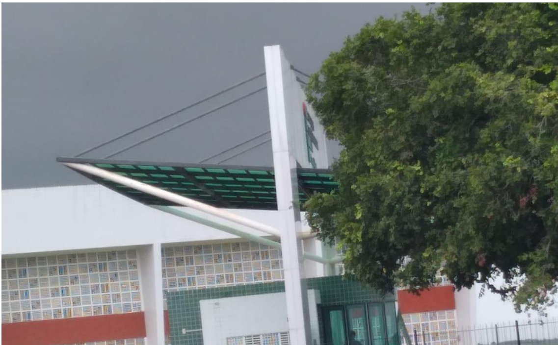
Foto: estrutura da guarita em policarbonato
