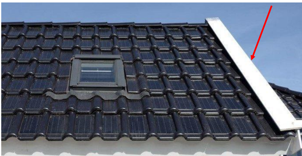
Imagem ilustrativa: algeroz de um telhado
