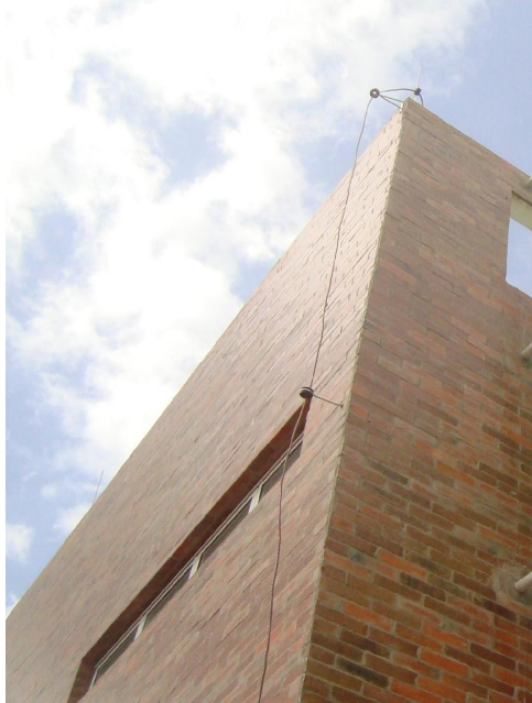
Foto: Descida do sistema de SPDA.
