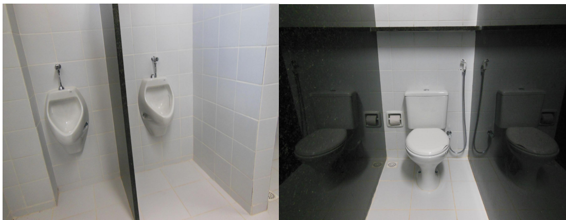
Foto: divisória de granito em banheiro
