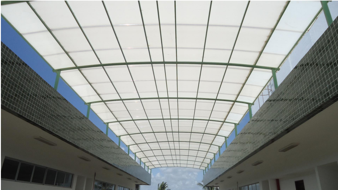
Foto: cobertura entre blocos em policarbonato
