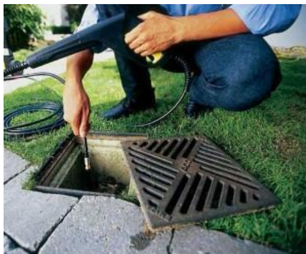
Imagem ilustrativa: limpeza de caixa de drenagem pluvial
