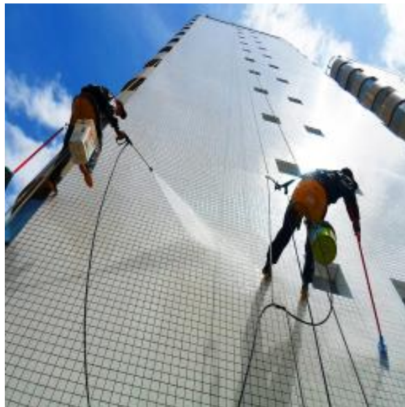
Imagem ilustrativa: lavagem de fachada com revestimento cerâmico
