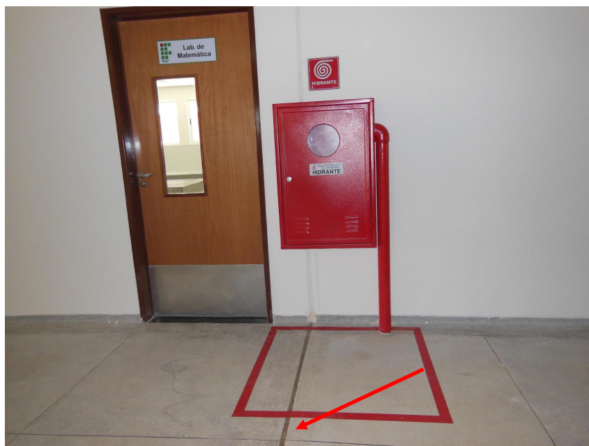
Foto: junta de dilatação do piso em granilite
