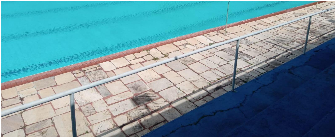
Foto: guarda-corpo em aço galvanizado
