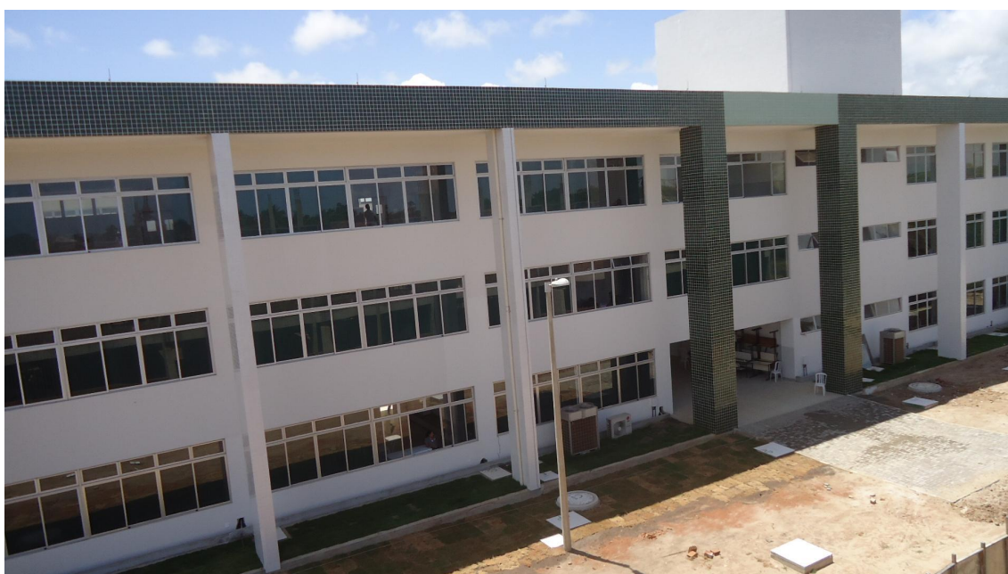
Foto: esquadrias de alumínio e vidro - Campus Cabedelo
