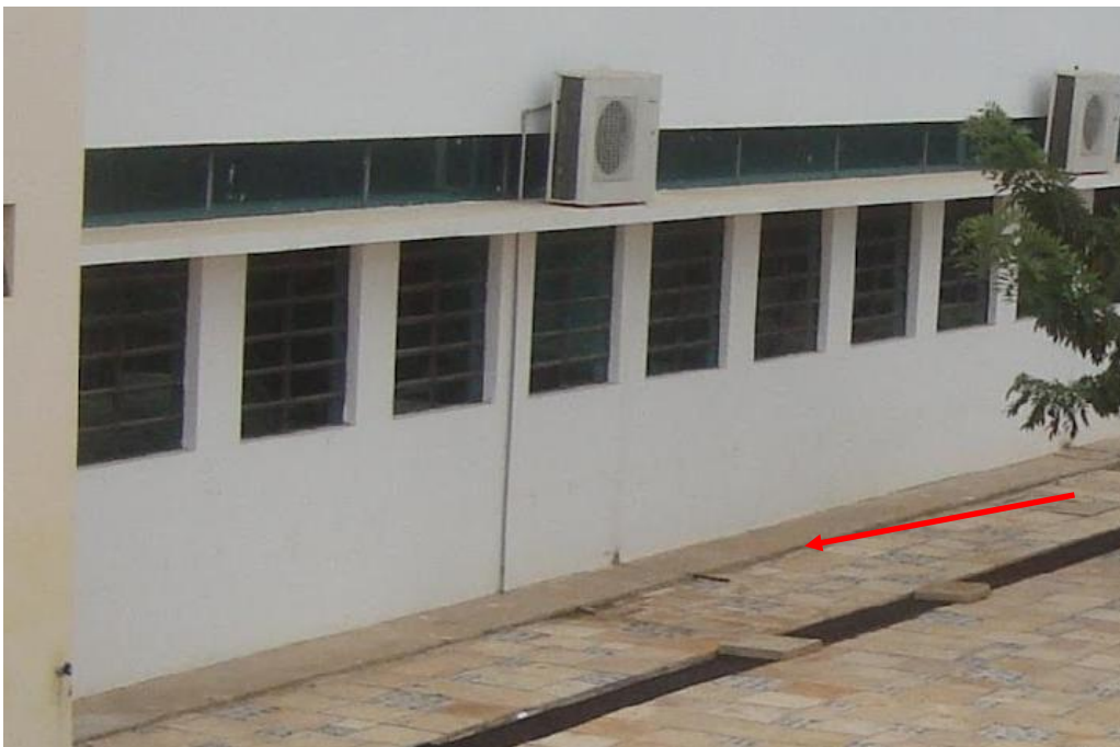
Foto: calçada de contorno em piso cimentado
