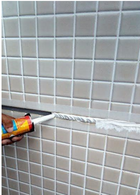
Imagem ilustrativa: aplicação de selante poliuretano na junta de dilatação de fachada
