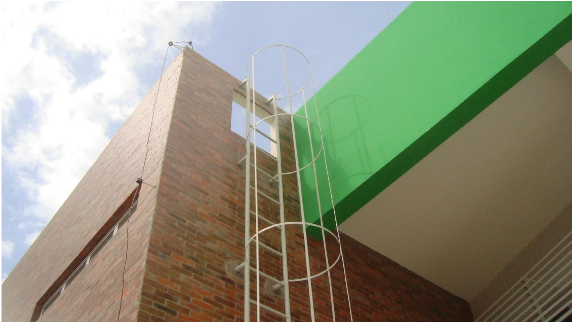
Foto: escada em aço galvanizado
