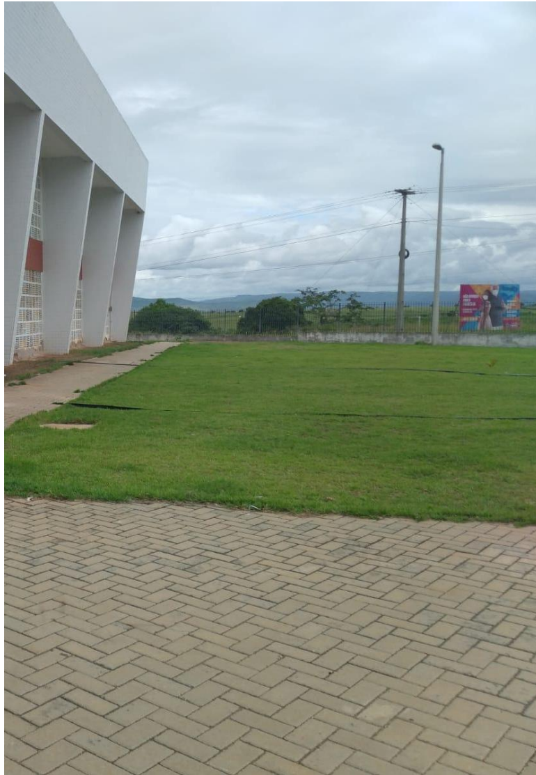
Foto: piso em bloco intertravado
