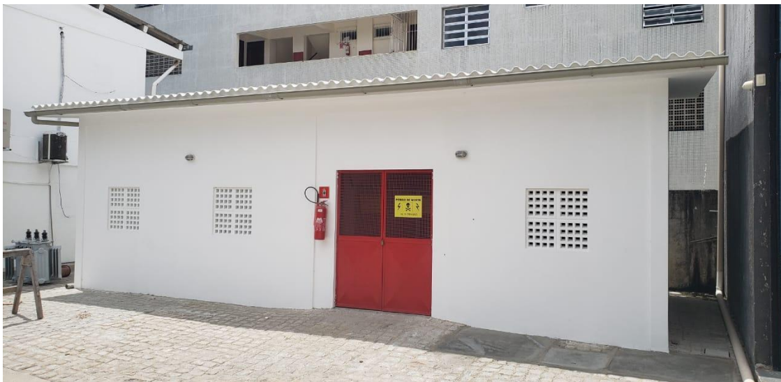
Foto: abrigo em subestação do Campus João Pessoa
