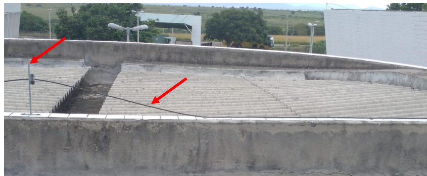
Imagem ilustrativa: sistema de proteção contra descargas atmosféricas.
