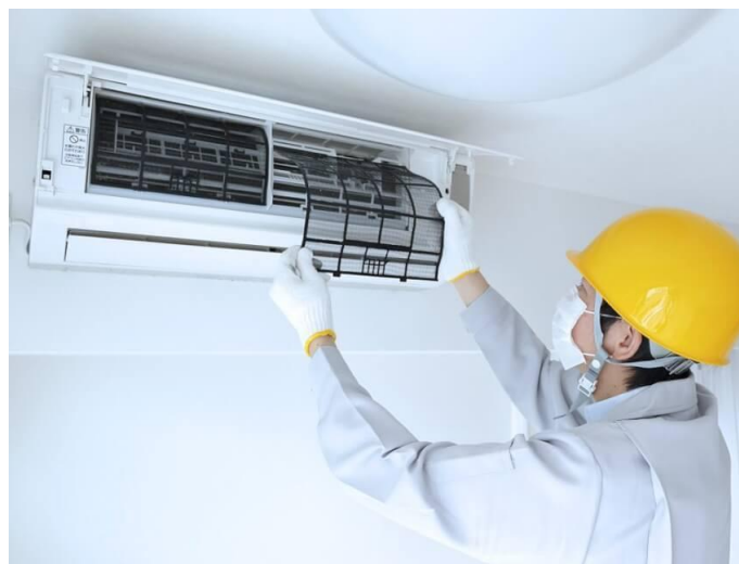
Imagem ilustrativa: retirada do filtro de poeira para limpeza.
