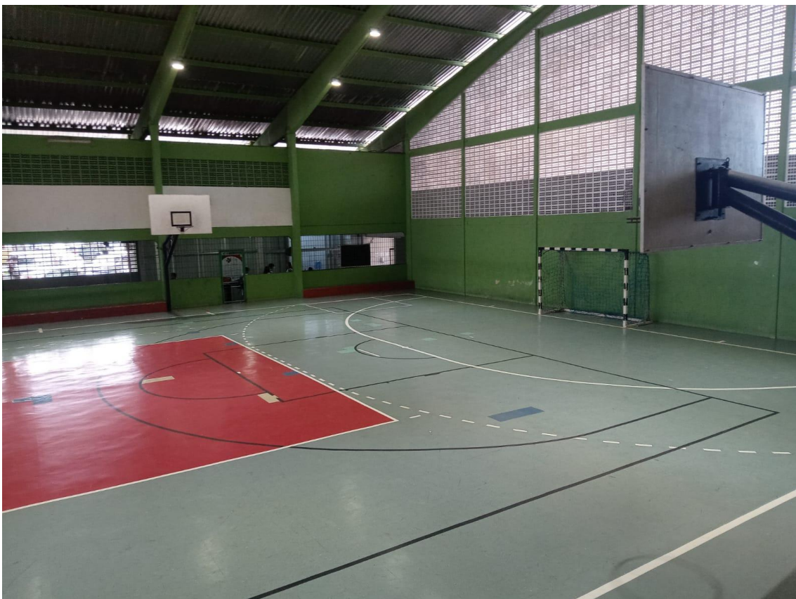
Foto: Piso em concreto com acabamento em pintura
