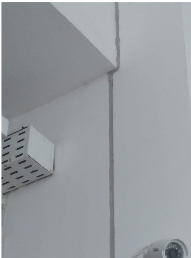
Foto: juntas de dilatação da parte interior da edificação
