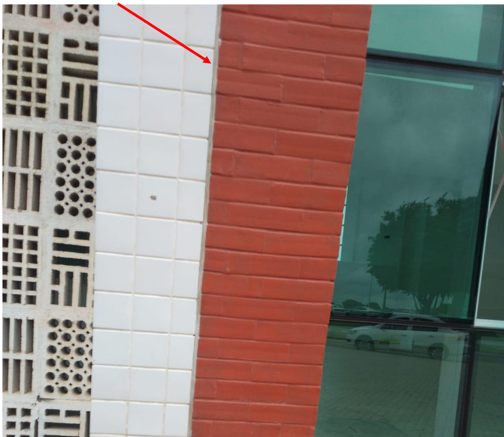
Foto: junta de dilatação de fachada
