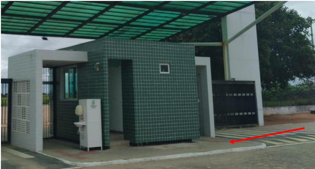
Foto: acesso da guarita em piso cimentado
