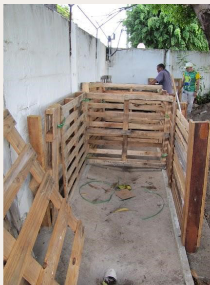
FIGURA 38 – Detalhe da construção dos primeiros módulos - já com tubo para coleta do chorume Fonte: ANDRADE, Laura (2016).
