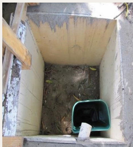
FIGURA 11 – Detalhe da composteira mostrando a estrutura destinada à coleta do chorume Fonte: ANDRADE, Laura (2016)
