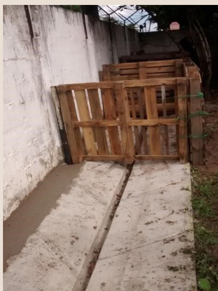
FIGURA 37 – Detalhe da construção dos primeiros módulos - vala para coleta do chorume Fonte: LEAL, Claudiana (2016).
