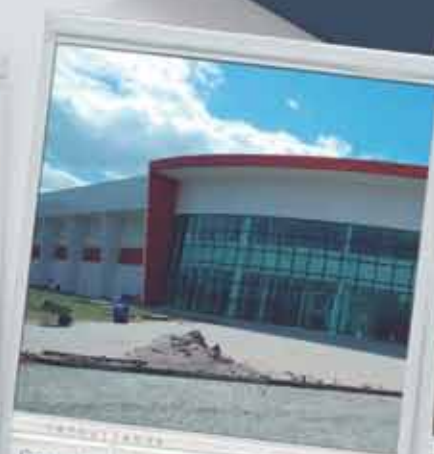
Construção do Campus Guarabira
