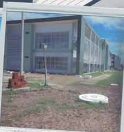
Bloco administrativo e biblioteca do Campus Cabedelo.
