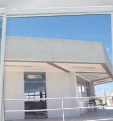
Construção do restaurante do Campus Campina Grande
